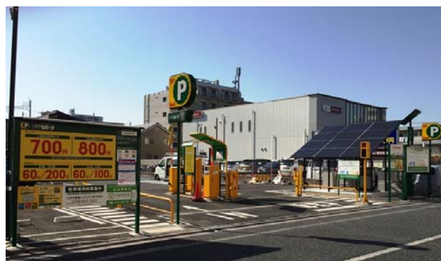
「三井のリパーク」武蔵浦和駅前第2駐車場 全景
