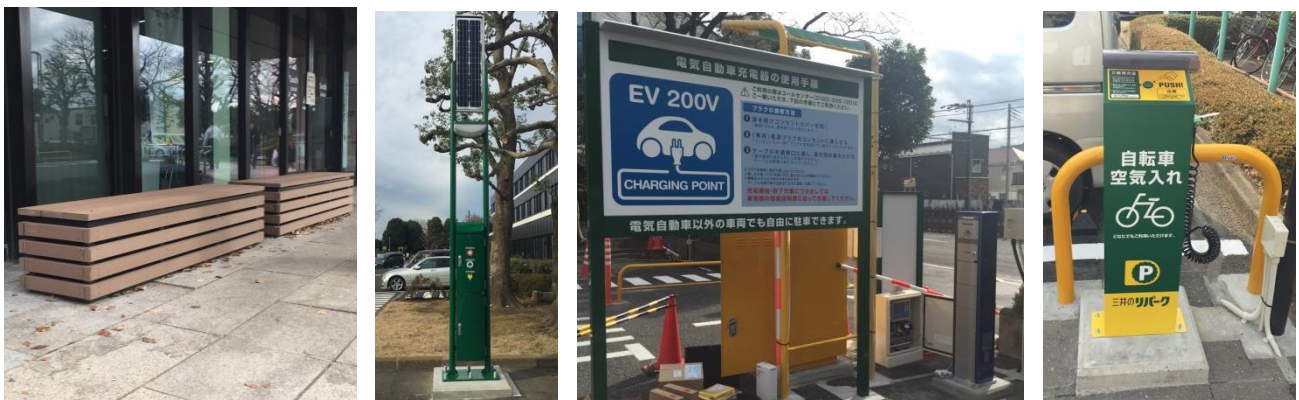
左から：再生木材ベンチ(簡易テント・簡易トイレ格納)、ソーラーLED 街路灯(防災グッズ格納)、電気自動車充電器、エアステーション(自転車用電動空気入れ)
